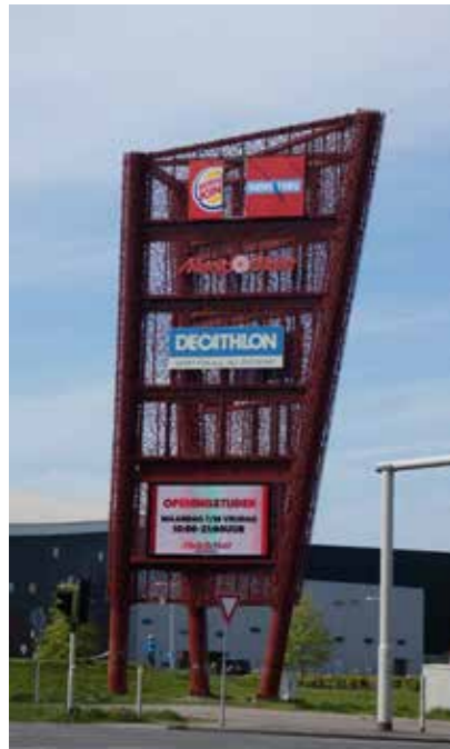
Faulkner Brouwns Architects Reclamezuil 2014/Voorwaarts/Omnisport Toegepaste kunst/Stalen staketsel met uitgesneden fietsen. Op de zuil staat reclame van de winkels van winkelcentrum De Voorwaarts en een LED-scherm waarop reclame-uitingen te zien zijn en eveneens evenementen worden aangekondigd.
