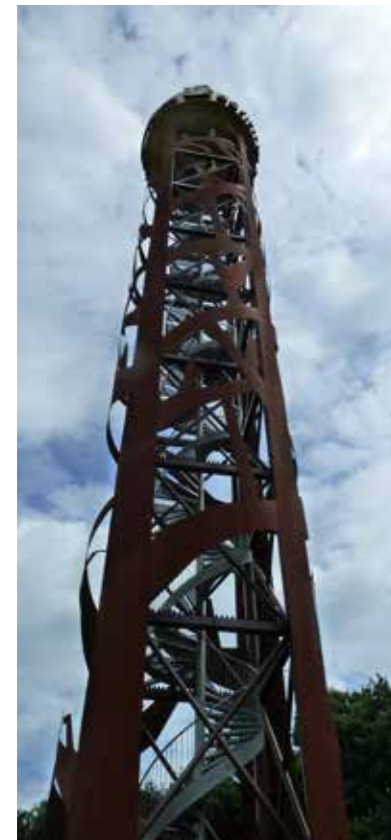
Van den Brink Staalbouw Kunstzuil/Klimtoren Apeldoorn Agrifirm. Een 37 meter hoog ontwerp van Van den Brink Staalbouw in opdracht van Agrifirm.
